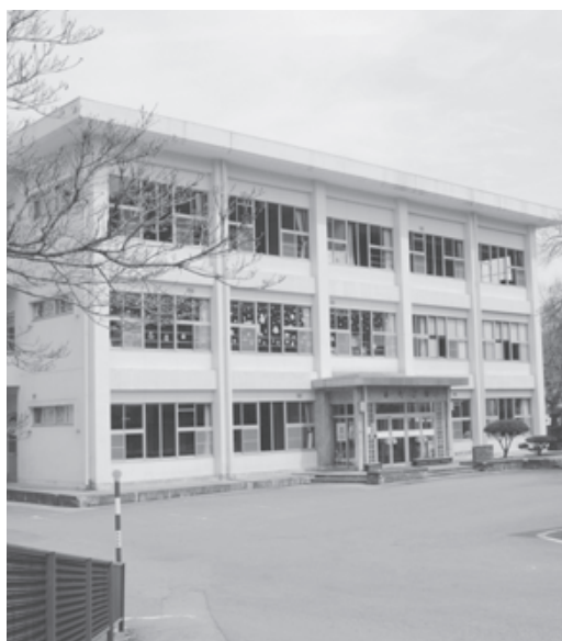
改修工事を行うあたご館
