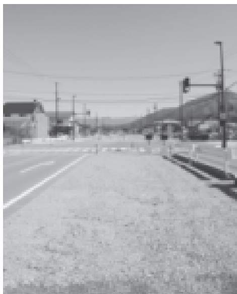
整備が進む国道289号バイパス
