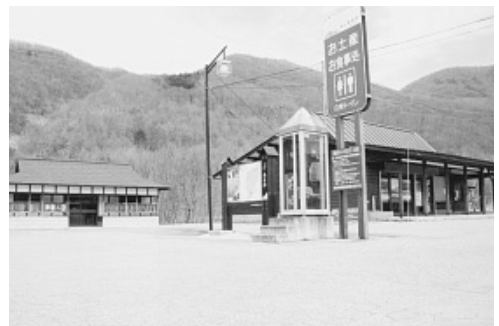
国道352号線沿いの公衆トイレ(館岩地域)
