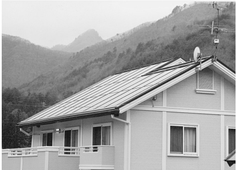
自然のエネルギーを利用する太陽光発電システム
