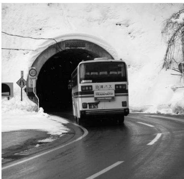
国道352号の中山トンネル
