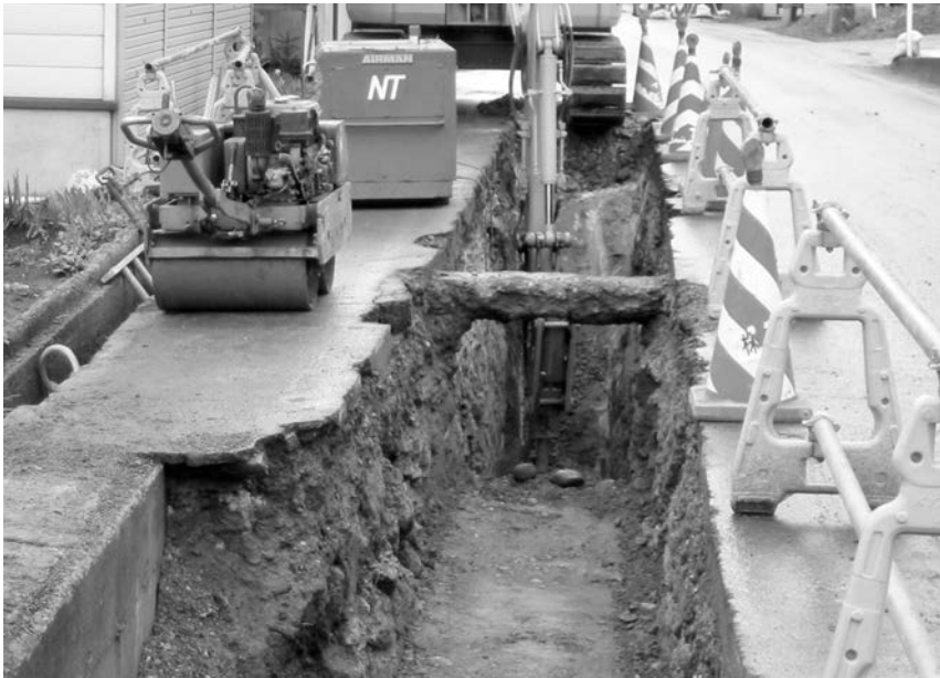
南郷地域の下水道工事
