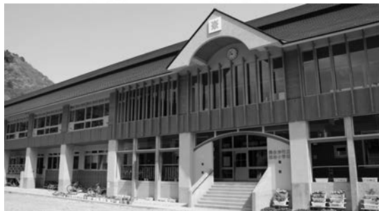
完成した館岩小学校新校舎
