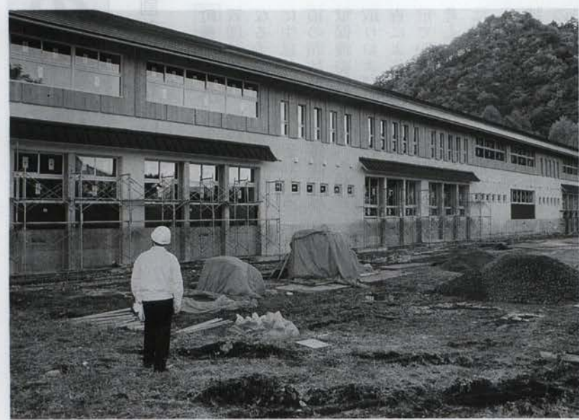
工事が再開された館岩統合小学校
