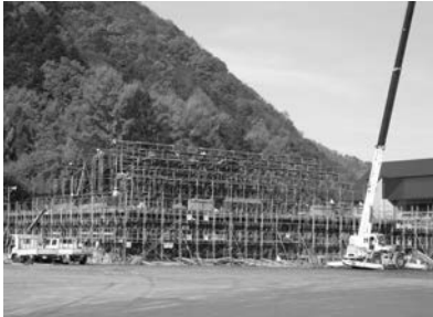
館岩小学校体育館建設現場
