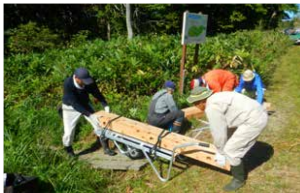
老朽化した木道を整備
