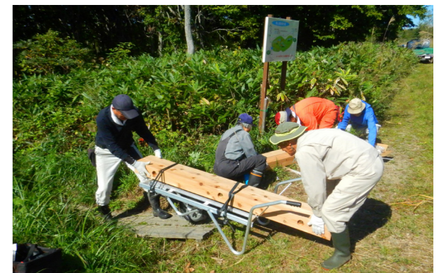
老朽化した木道を整備
