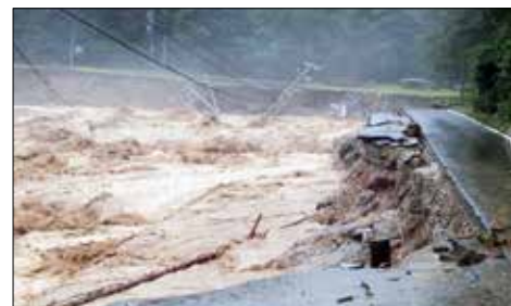
▲平成27年10月号(No.115) 関東・東北豪雨災害発生。桧沢川・荒海川・館岩川が氾濫し、道路が崩落するなどの甚大な被害を引き起こした。
