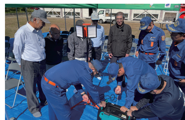
発電機の使用方法を確認
