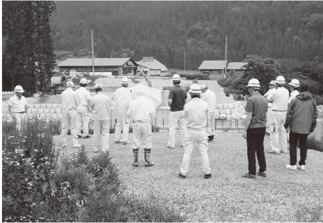
現地調査のようす (町道大新田1号線 南郷橋下部工工事 大新田地内)
