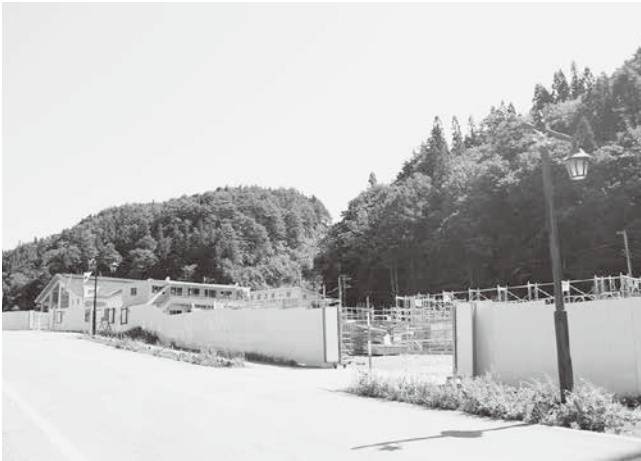
建設工事が進む新さゆり荘（令和元年9月27日撮影）
