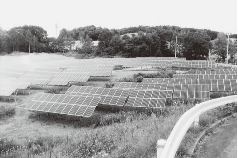
館岩地域大久保地内(白樺牧場跡地)で建設工事が進む太陽光発電施設 令和2年9月に売電開始を予定している
