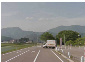
びわのかけ保育所入口の町道拡幅
