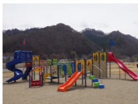
びわのかげ運動公園の遊具改修工事
