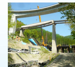
銀橋撤去工事(中山峠)
