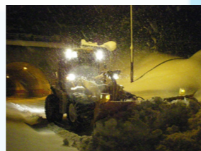
除雪作業(国道400号)
