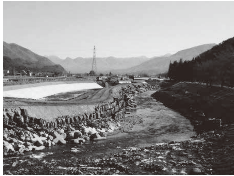
松沢川改修工事のようす（平成 29 年 12 月 3 日撮影）
