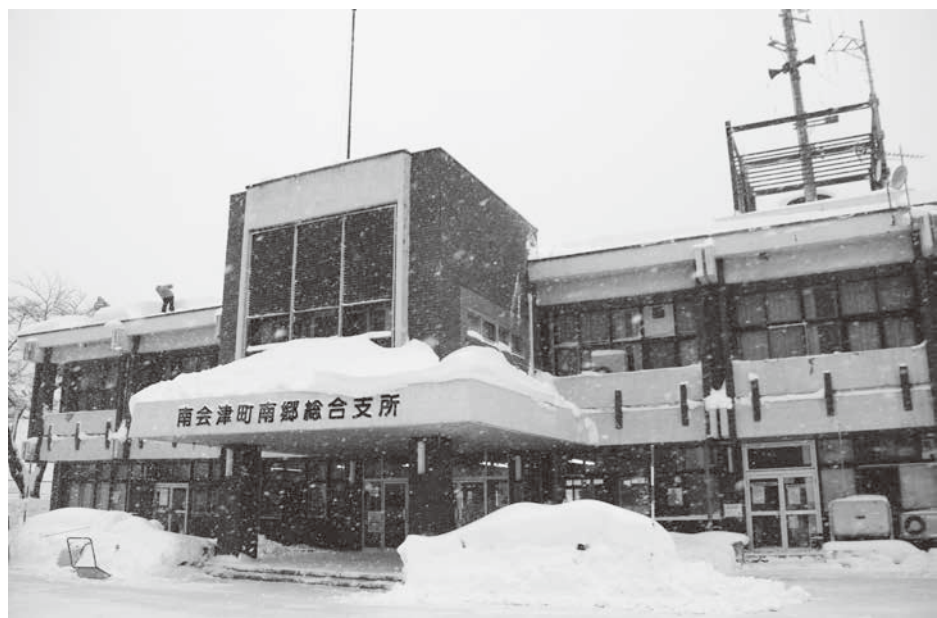
耐震対策を検討している南郷総合支所
