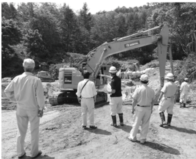
現地調査のようす（番屋線 道路災害復旧工事）
