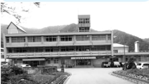
大規模改修工事が行われる南郷総合センター
