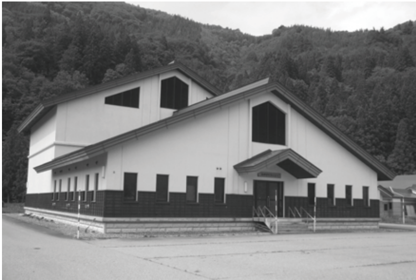
更新工事を行う南郷浄化センター
