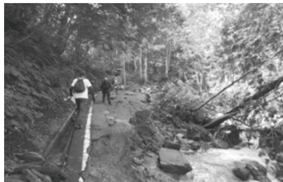
町道106号線の災害状況（平成27年9月12日撮影）
