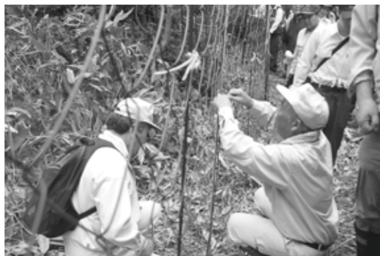
シカ侵入を防ぐため、大江湿原の周囲を囲む柵設置のようす
