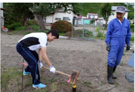
地籍調査で杭を打ち込む渡部さん
