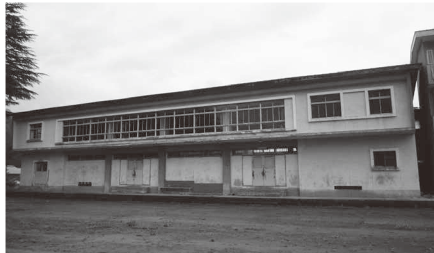
解体が予定されている旧伊南小学校体育館
