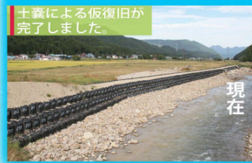
福米沢地区 堤防決壊箇所 ※ に土壌を積み上げています。
