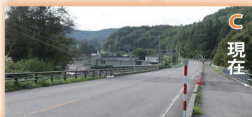
針生地区(株)芳賀沼製作付近 現在、片道通行は解消されています。
