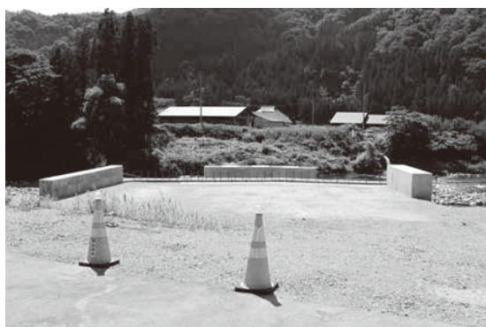
南郷橋架替工事現場 (南郷地域大新田地内)
