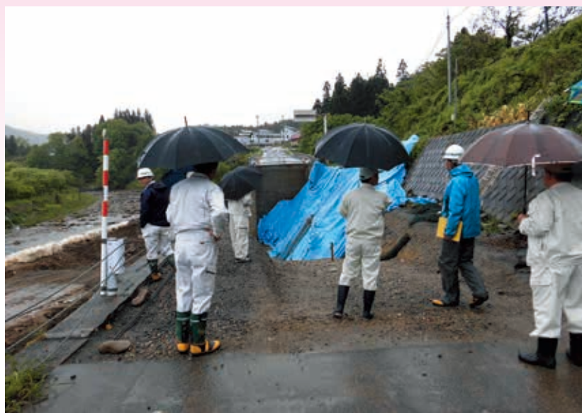
現地調査のようす（町道川島・藤生線災害復旧工事（補強土壁工））
