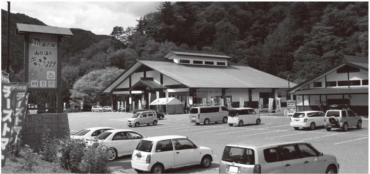
年々利用者が増加している道の駅「きらら289」
