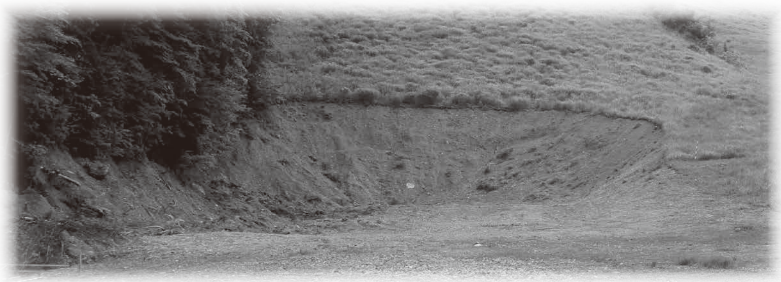
だいくらスキー場シャドーコースの崩落現場
