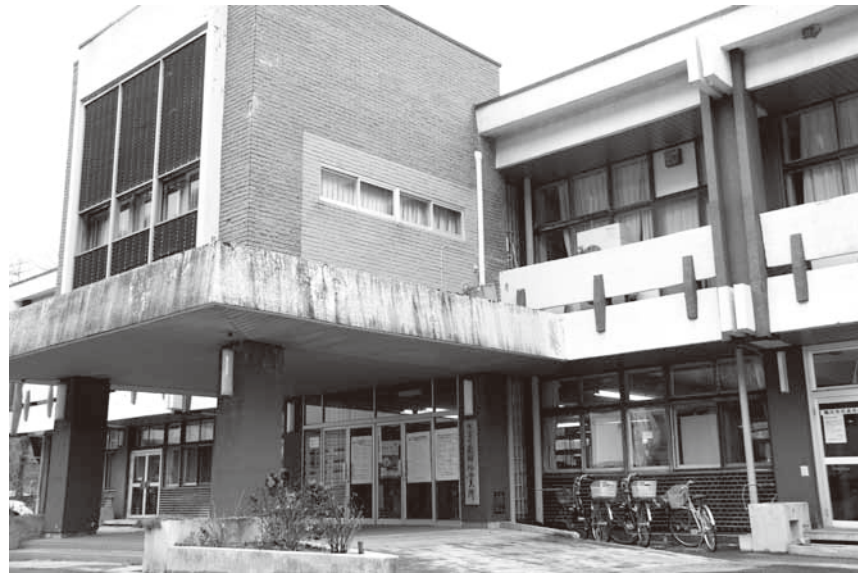
築48年が経過した南郷総合支所（昭和42年7月竣工）
