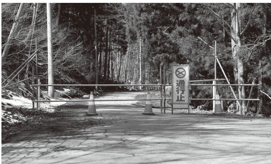
駒止湿原へ続く旧国道289号線の早期開通が望まれる
