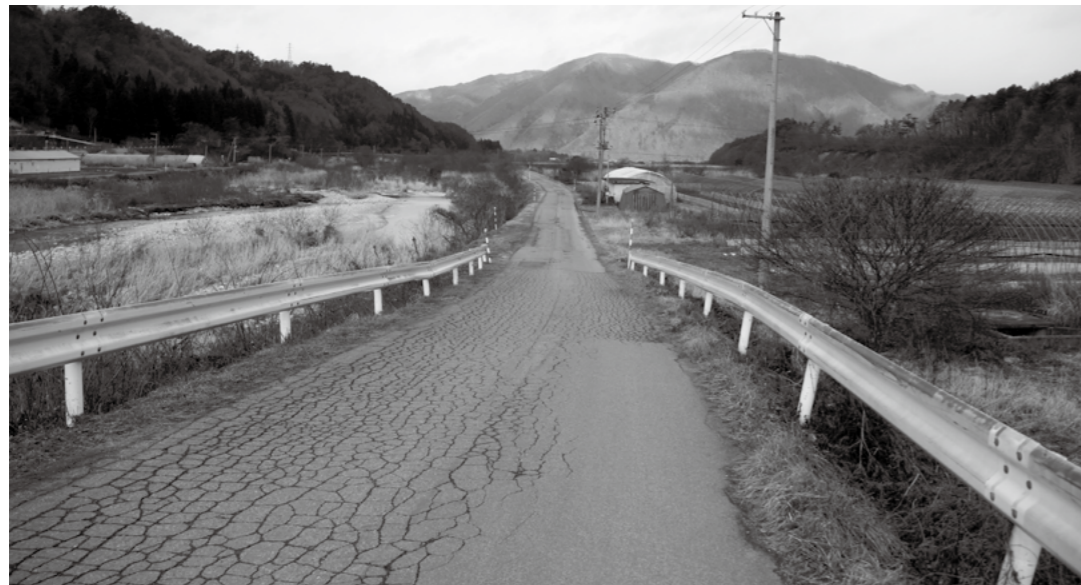
道路整備で要望を有利に(水無川右岸沿い)
