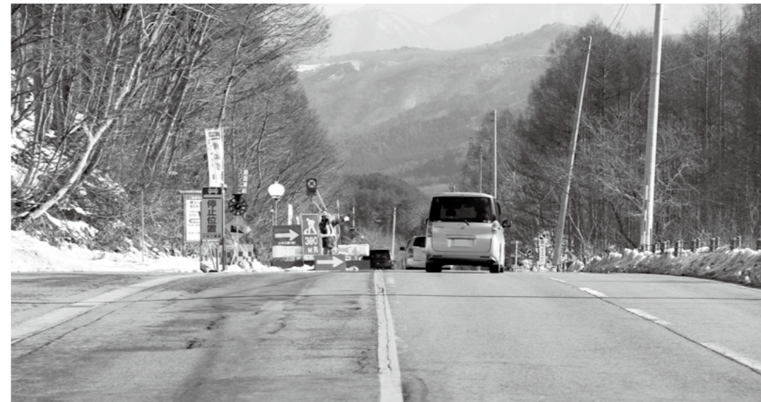
国道289号針生地内駒止トンネル付近の片側通行区間
