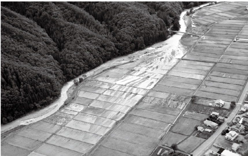
関東・東北豪雨災害による堤防の決壊（田島地域金井沢地区） 近くには民家が立ち並ぶ
