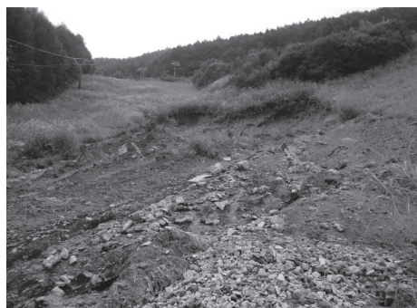
たかつえスキー場の崩落現場
