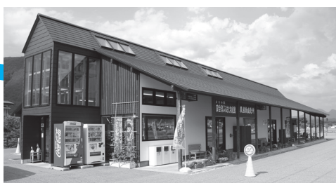
町の駅「南会津ふるさと物産館」(田島地域)
