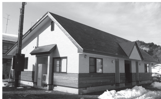
建て替えが進む町営住宅寺前団地
