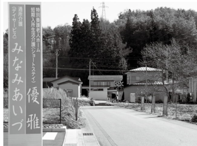
折橋踏切 (写真奥)
