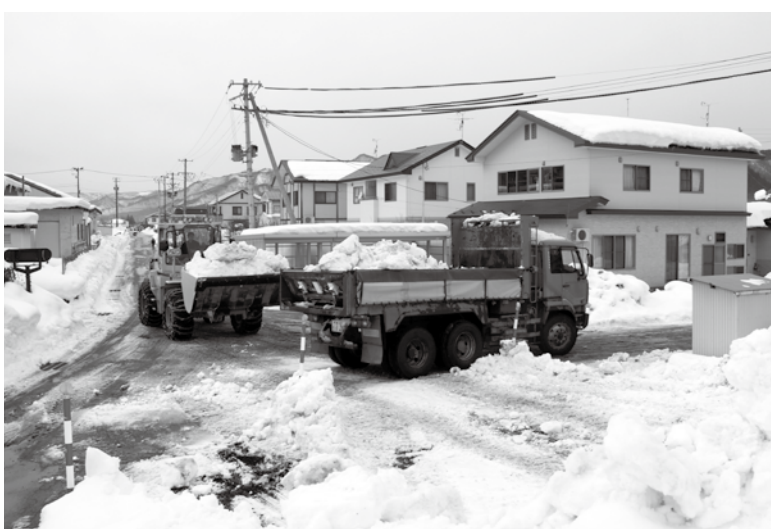
町道の排雪作業のようす
