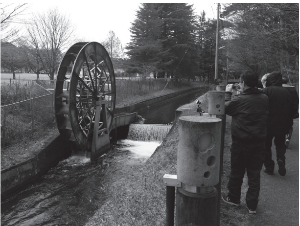
水力を利用した発電事業の取り組み事例 (那須野ヶ原水ウオーターパーク内)
