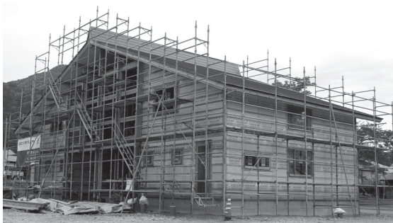
建設が進む新規就農者就農促進住宅 (南郷地域下山地内)
