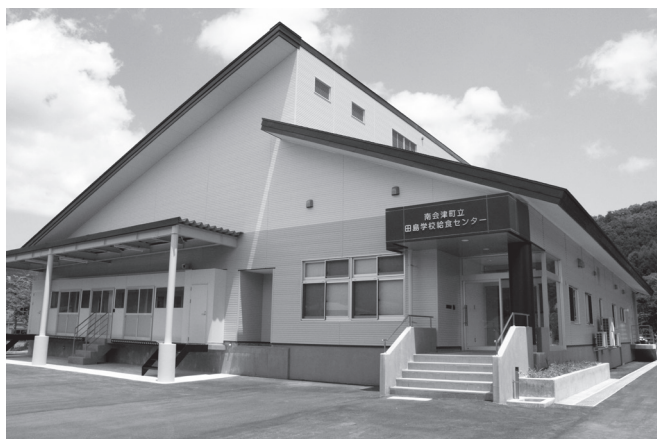
町立田島学校給食センター
