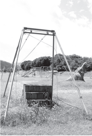
老朽化している一部の遊具
