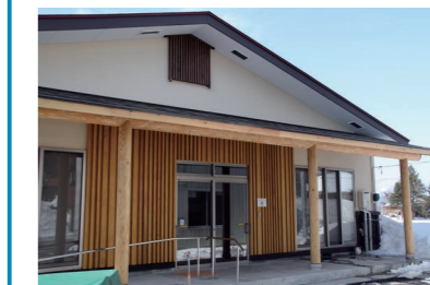
大規模改修された中荒井地区の集会施設
