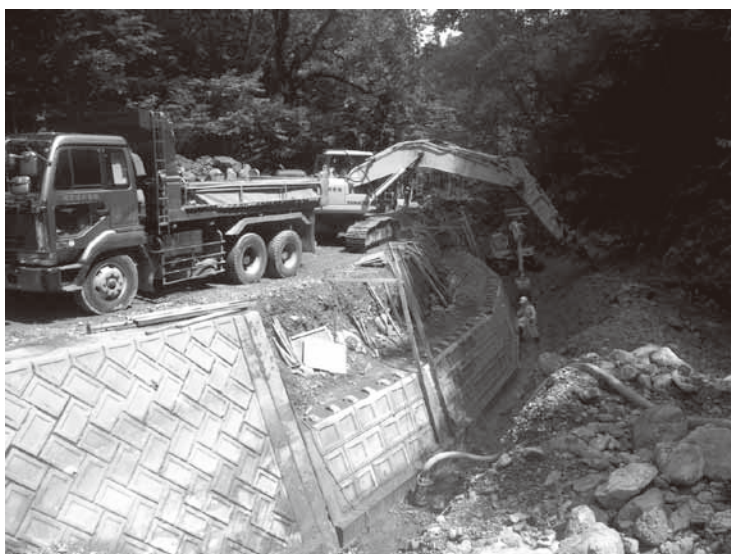
林道小塩・塩ノ岐線の災害復旧工事
