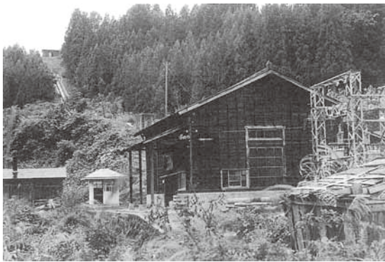
昭和43年まで稼働していた針生発電所
