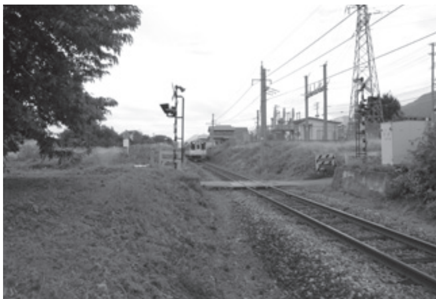
自動遮断機が無く幅員の狭い踏切
