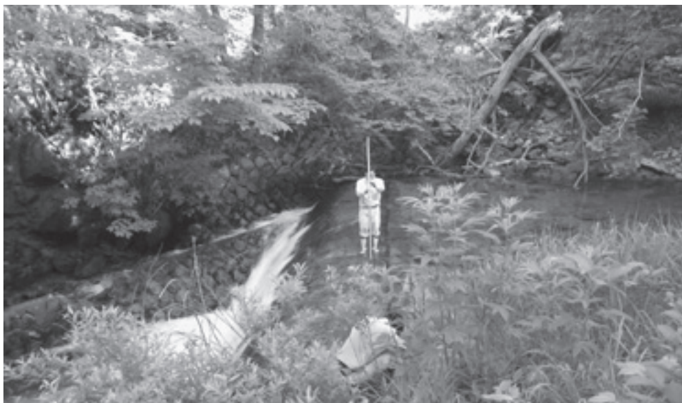
調査中の旧針生発電所の取水口
