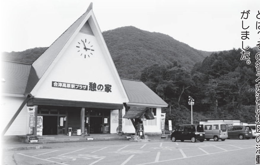
会津高原尾瀬口駅・憩の家は滝原地区のシンボルであるとともに、区指定避難場所にもなっています
